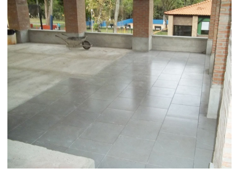
Salão da piscina em reforma
