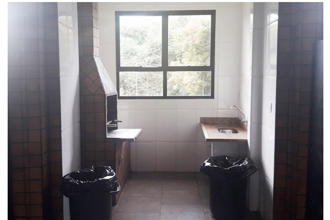
Vista interna da cozinha do salão após conclusão
