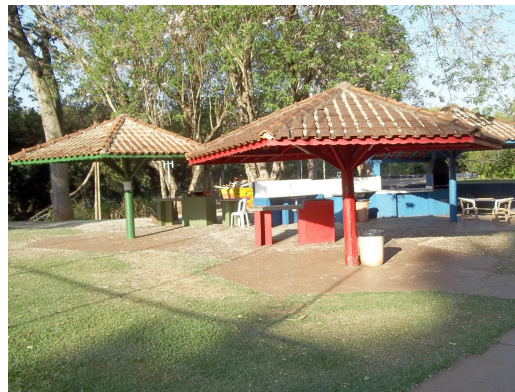
Quiosques antes da reforma
