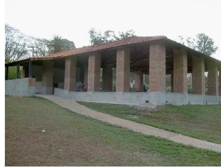
Salão da piscina em reforma
