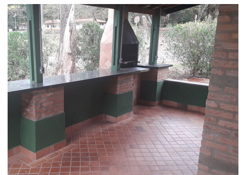
Salão da piscina após a reforma
