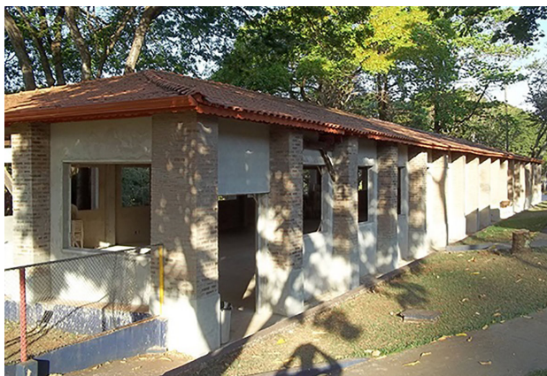
Vista externa do salão antes da conclusão
