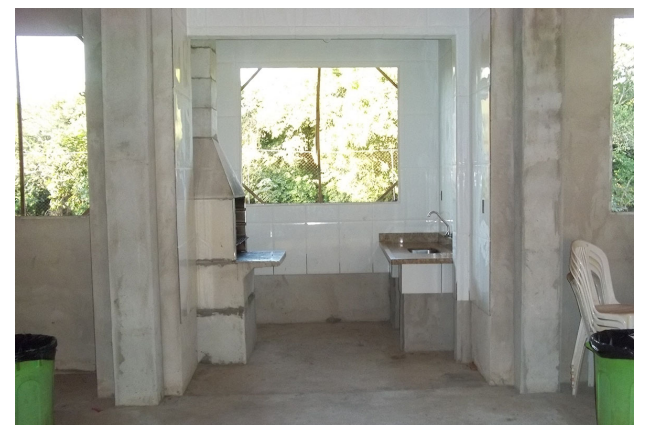
Vista interna da cozinha do salão antes da conclusão
