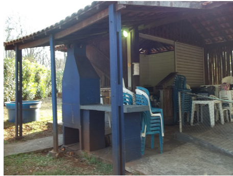
Salão da piscina antes da reforma
