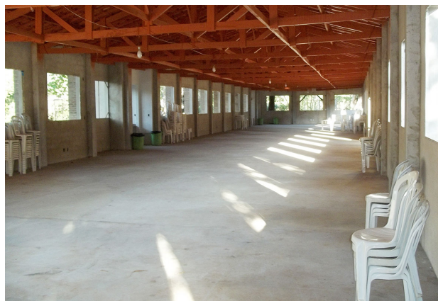
Vista interna do salão antes da conclusão
