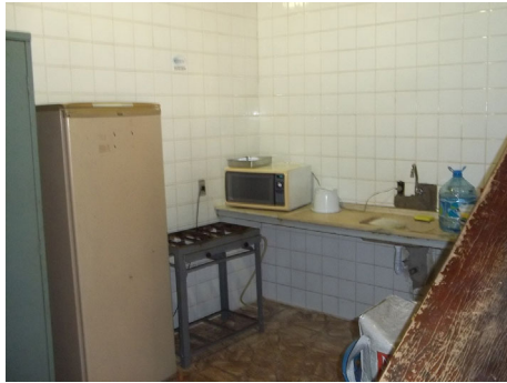
Salão da piscina antes da reforma
