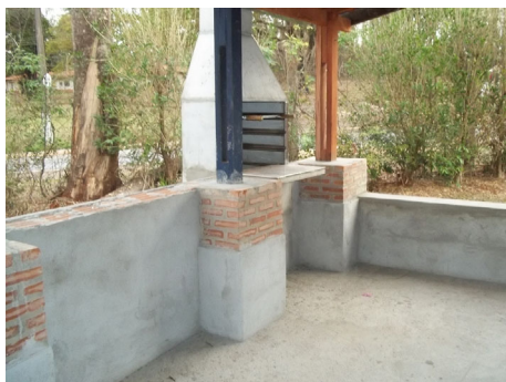
Salão da piscina em reforma
