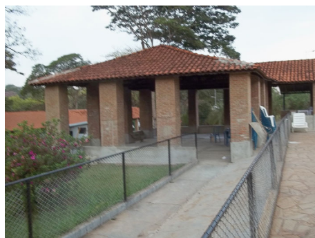
Salão da piscina em reforma
