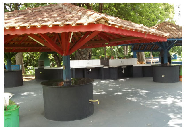
Quiosques após a reforma
